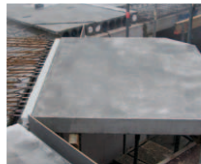
Poprzez fabrycznie wintegrowany (Schöck-Isokorb) kosz izolacyjny Schöcka uzyskuje się pewne termiczne oddzielenia pomiędzy balkonem a stropem kondygnacyjnym, tak że niemożliwe jest powstanie mostków cieplnych.
