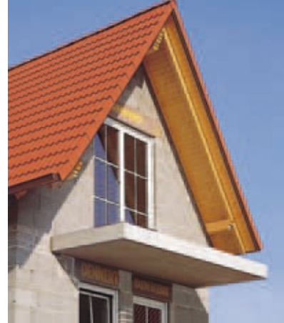
Poprzez fabrycznie wintegrowany (Schöck-Isokorb) kosz izolacyjny Schöcka uzyskuje się pewne termiczne oddzielenia pomiędzy balkonem a stropem kondygnacyjnym, tak że niemożliwe jest powstanie mostków cieplnych.
